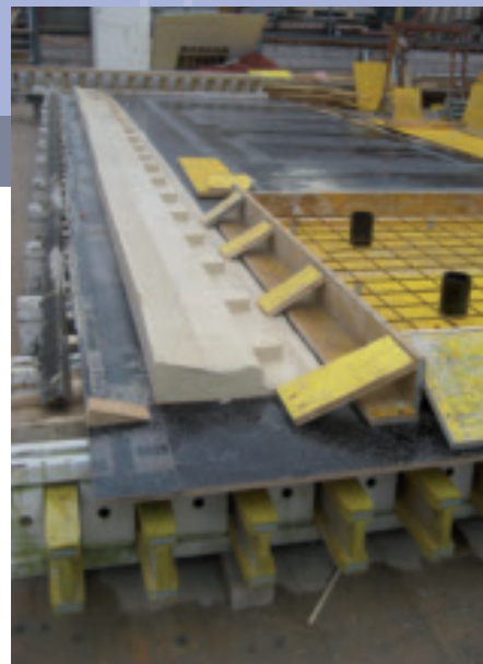
Die Betonmatrizen von Noe zeichnen das genaue Positiv der alten Gebäudefassade.
